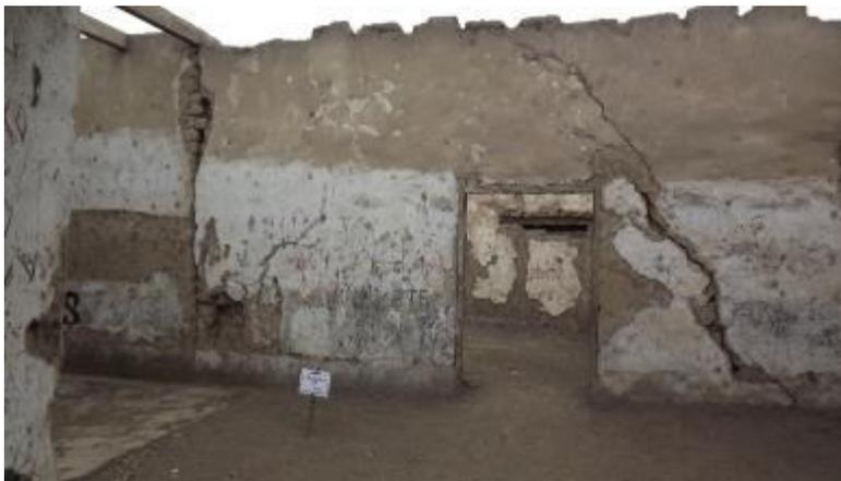
*Se ve claramente el asentamiento de la pared por falla del suelo sobre el que se asienta (abajo está la huaca de Punchao). La grieta del lado izquierdo es más amplia en la parte superior que en la inferior, es decir, la falla del suelo ha sido en la zona central.*
