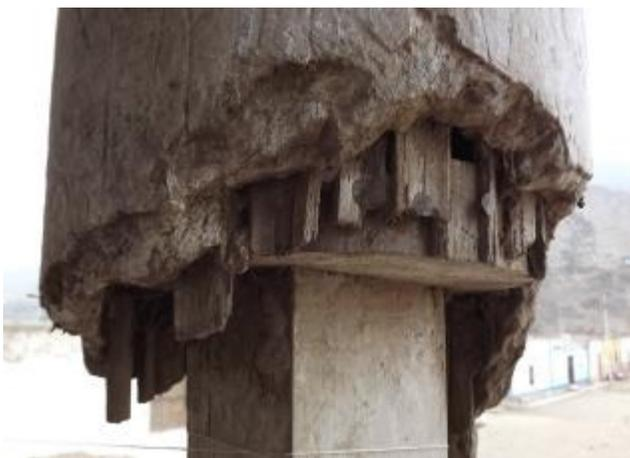
*Detalle del estado de las columnas de la loggia de la fachada principal y de la técnica de construcción de las mismas: un pie derecho de madera a la que se le adosa maderas para dar la forma circular con éntasis, y caña que se clava (con clavos hechos a mano) caña chancada para proceder al enlucido de barro con acabado de barro más fino.*
