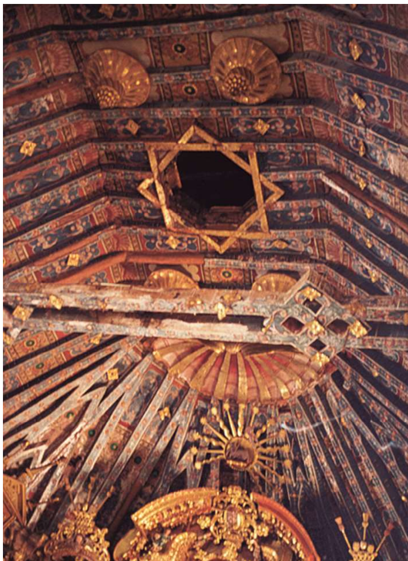
Figura 17. Techumbre del presbiterio de la iglesia de San Pedro de Andahuaylillas, Cusco. Perú.
