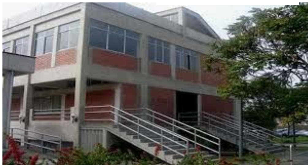
Centro de Investigación — Pabellón Cubero
