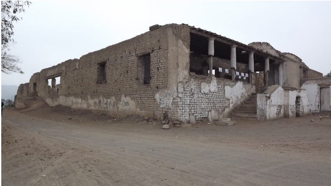
Vista del estado actual (setiembre de 2012) de la casa de hacienda Punchauca, desde el ingreso principal, se aprecia la loggia delantera y las escaleras que evidencian la sobre elevación. Foto del autor 2012
