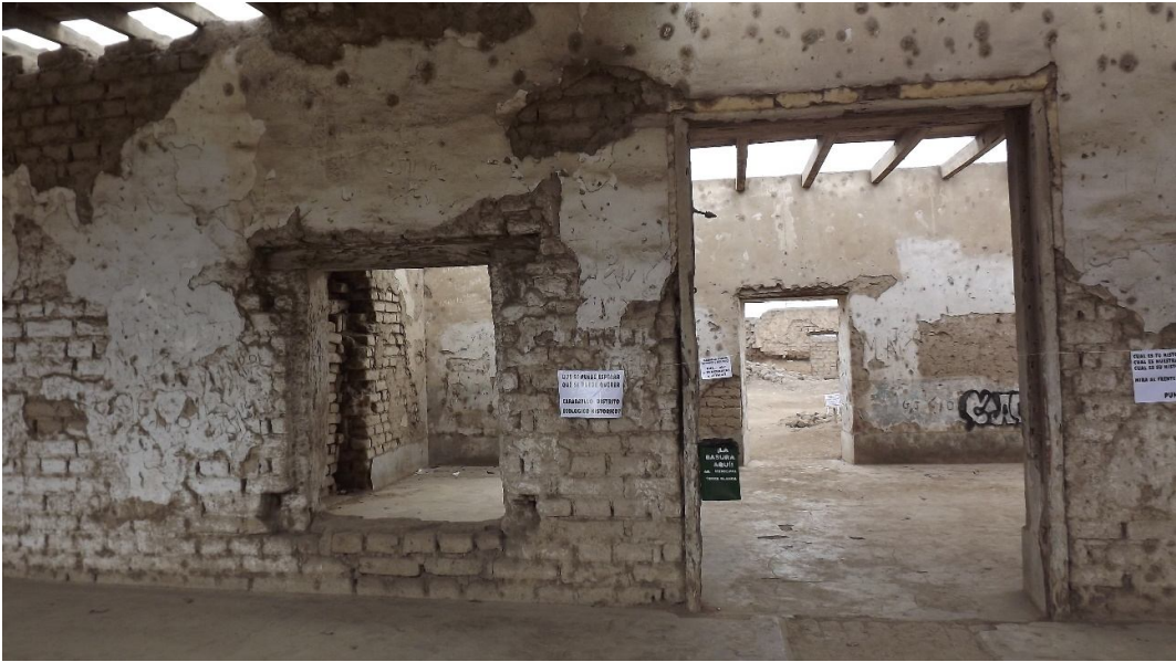
Vista de la puerta (y ventana) de ingreso al gran salón principal y a la cuadra 3 (hoy destruida). Foto del autor 2012
