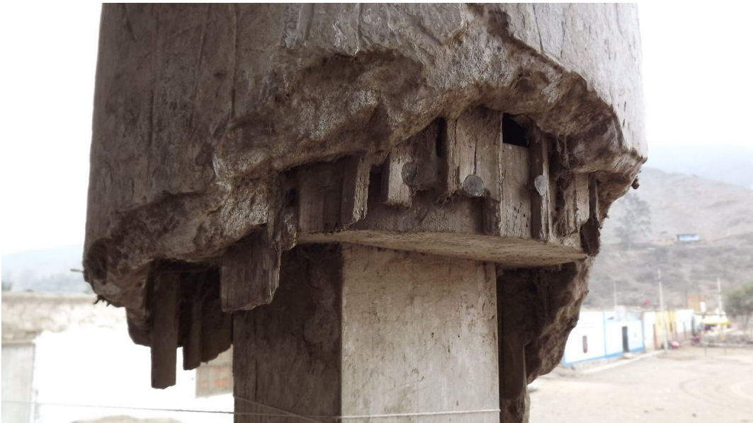
Pormenor de la estructura de las columnas: un pie derecho de madera a la que se le adosa maderas para dar la forma circular con éntasis, y caña que se clava (con clavos hechos a mano) caña chancada para proceder al enlucido de barro con acabado de barro más fino. Foto del autor. 2012
