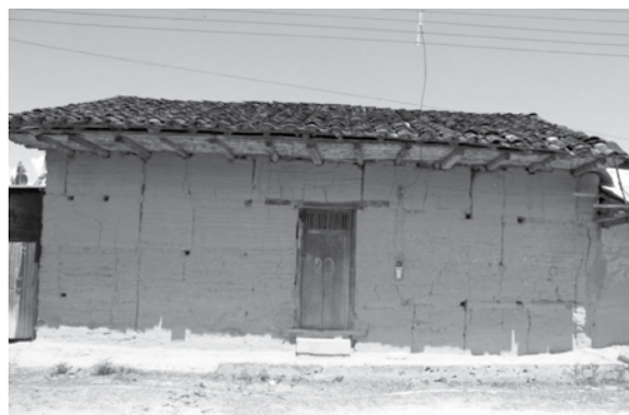
Figura 1. Una casa típica en tapial y cubierta de teja, en el barrio de Wayku (Foto: A. Scaletti, 2013)
