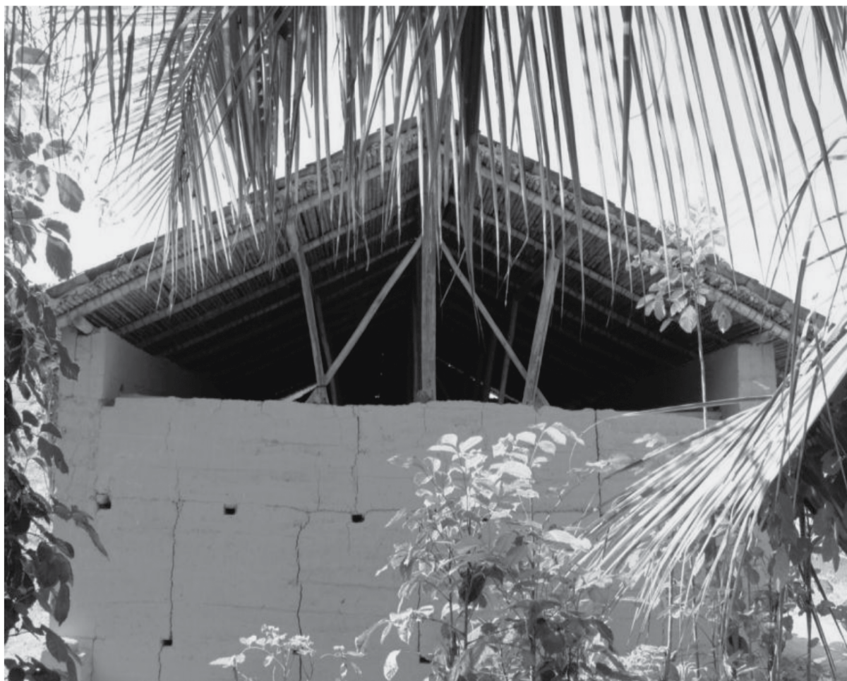
Figura 2: Una casa típica de Wayku, mostrando la abertura para la ventilación del terrado (Foto: B. Candia, 2013)
